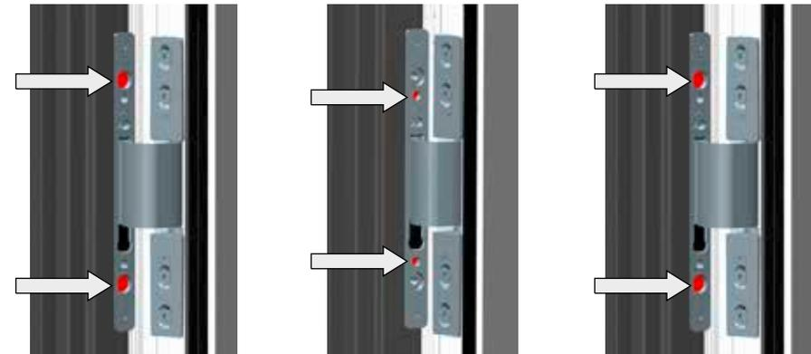
1. Die Senkkopfschrauben (Pfeile) am Flügelband leicht lösen.
