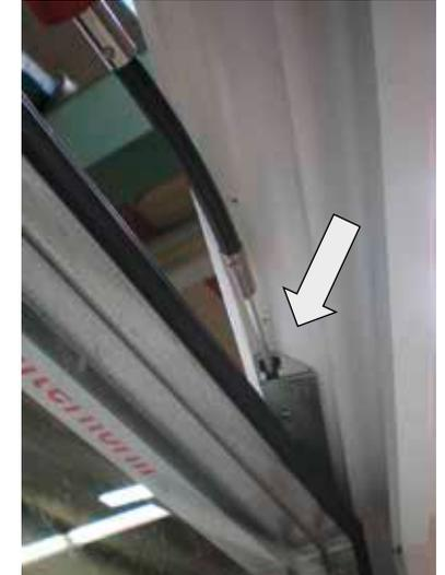
Anheben und Absenken des Flügels mit Inbusschlüssel SW4.
