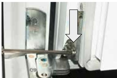
Anpressdruckverstellung mit Inbus-
