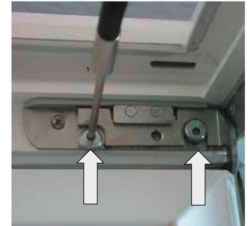
Sicherungsbolzen an beiden Kipplagern mit Inbusschlüssel SW5 um 180° drehen.
