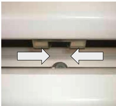
Der Mitnehmer des Oberlichtbeschlages muss beim Schließen des Flügels den Verriegelungsbolzen wieder einfangen.
