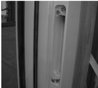
Bei ausgehängt geliefertem Flügel sind die Befestigungsschrauben im Rahmen eingedreht, diese sind zu entfernen.
