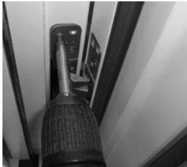
Bänder ohne verkanten in die Aufnahme-metaschen gleiten lassen und jedes Band vorerst mit einer Fixierungsschraube positionieren.
