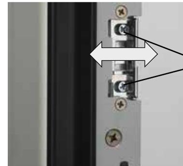
Regelt den schlossseitigen Anpressdruck bei Fallen-Riegelschloss und Mehrfachverriegelungen.
