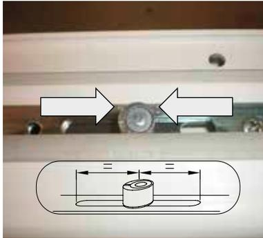
Greift ein Mitnehmer des Oberlichtbeschlages in den Flügelbeschlag ein, ist unbedingt darauf zu achten, dass ein unabsichtlich verschobener Verriegelungsbolzen des Flügelbeschlages wieder mittig ausgerichtet wird, da sich ansonsten der Flügel nicht mehr schließen lässt.
