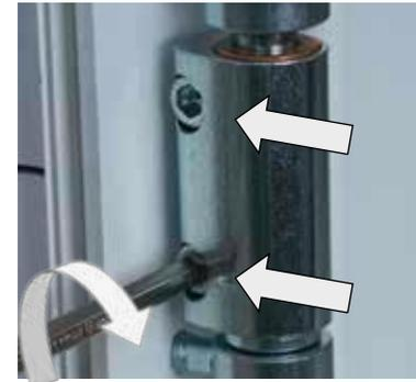
Durch Verstellen beider Schrauben am Mittelteil des Drehbandes mit Inbusschlüssel SW5 erfolgt die Seitenverstellung.
