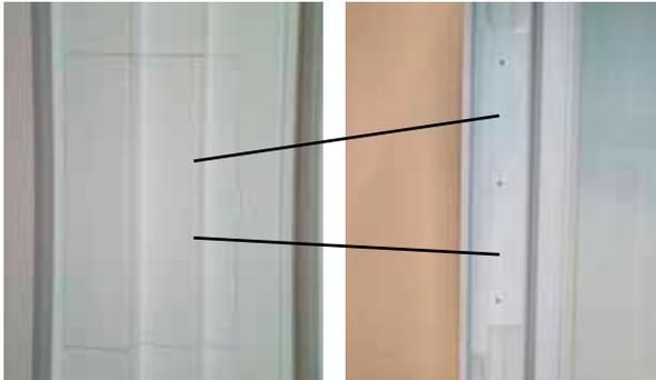
Filterdeckel entweder mit dem Fingernagel oder unter vorsichtiger Zuhilfenahme eines Flachschraubendrehers öffnen. Dabei etwas Druck Richtung Rahmenseite ausüben.
