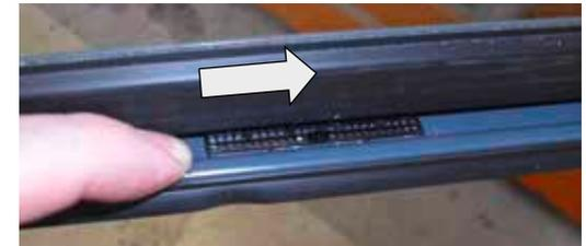
Öffnen sie im Winter die Schlitze wieder, um für eine gute Belüftung zu sorgen. Dadurch soll ein Beschlagen und Tauwasserbildung vermieden werden.
