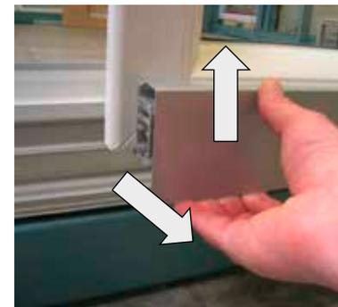
Abdeckprofil an der unteren Seite aus den Halteklips drücken und nach oben abheben.
