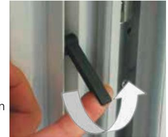
Durch das Verschließen der Lüftungsschlitze mit dem Gitter kann im Sommer ein Insektenbefall vermieden werden.
