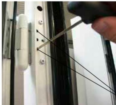
Beide Spannschrauben bis zum Anschlag lösen.
