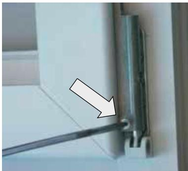
Einstellung der Drehhemmung mit Inbusschlüssel SW2,5 bei Anschlag rechts bei geschlos-
