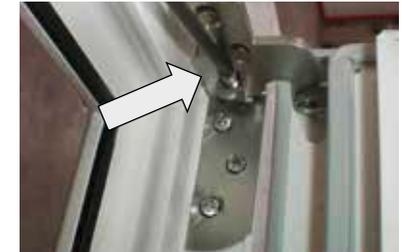
Verstellung bei Schwerlastbeschlag
