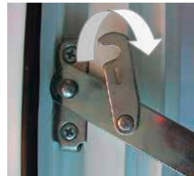
Um den Flügel für die Justierung ganz öffnen zu können, muss die Verriegelung der seitlich montierten Sicherungsscheren geöffnet werden.
