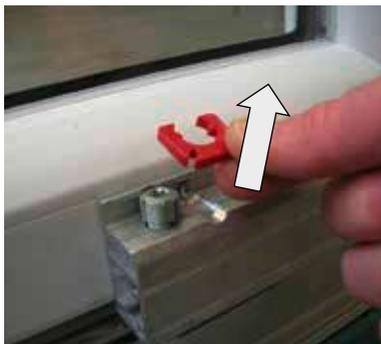
Verdrehsicherung von der Höhenverstelle schraube abnehmen.
