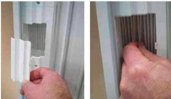
Neuen Filter in Pfeilrichtung in den Lüfter einsetzen.
