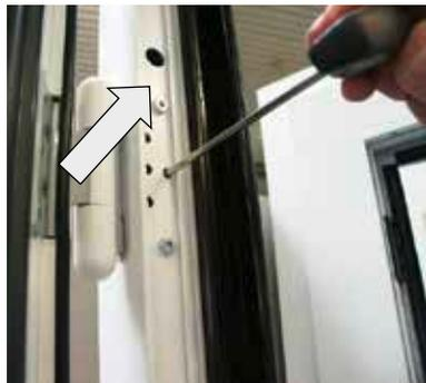
Anpressdruck so einstellen, dass die Dichtung keinen zu großen Druck im Bandbereich aufweist (Flügelüberschlag 14 – 15 mm).
