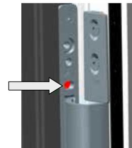
1. Für die Einstellung der Funktionsluft (Falzluft) muss die Schraube (Pfeil) in die jeweilige Richtung verdreht werden.
