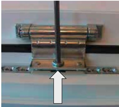
Heben und Senken des Flügels mit Inbusschlüssel SW4.
