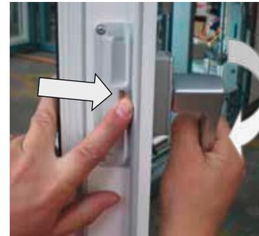
Flügel öffnen, am Getriebe die Wippe für Fehlschallsicherung drücken und Griff in die Verschlussposition bringen. Dabei werden die Verriegelungsklappen geöffnet.
